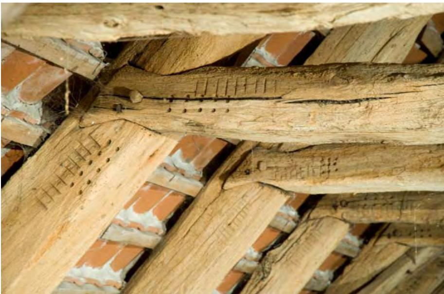
Abb. 4. Details der Holzverbindungen mit Zimmerzeichen unterschiedlicher Bauphasen (Foto: Erhard Preßler).
