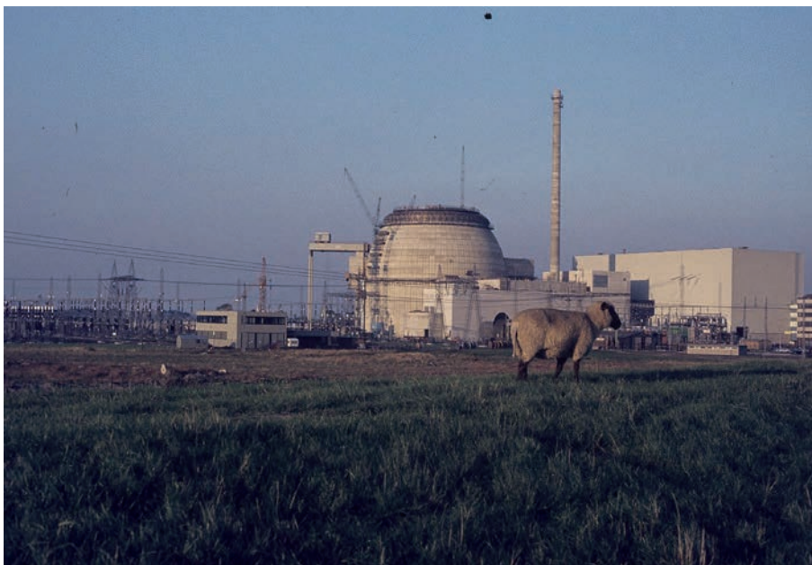
Abb. 2. Bildliches Zeugnis des sich im Bau befindlichen Kernkraftwerks Unterweser (Kernkraftwerk Kleinensiel) mit Schaf davor. BA-1716. Foto: Heinrich Kunst, Bildarchiv Oldenburgische Landschaft.
