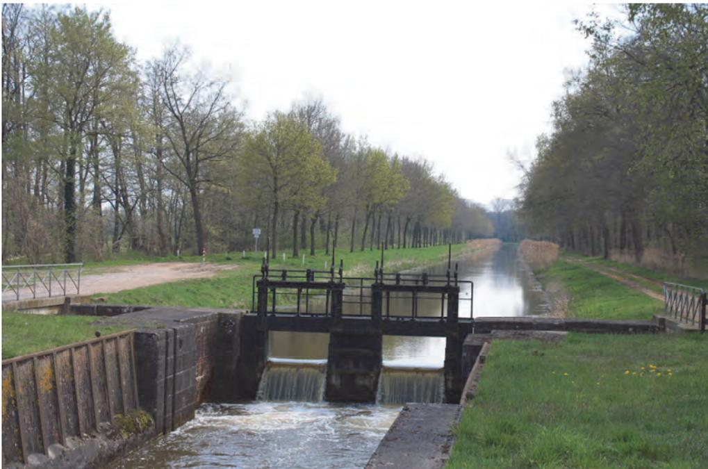
Abb. 6. Süd-Nord-Kanal, ehemalige Schleuse III bei Hohenkörben mit Leeableitung (die parallel fließende Lee verlegte man in den Kanal). Foto: K.-H. Peters.
