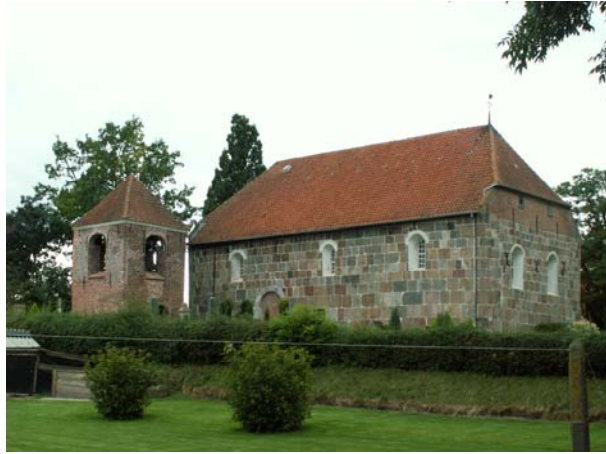
Abb. 1: Findlingskirche von Asel (Aufnahme August 2007).
